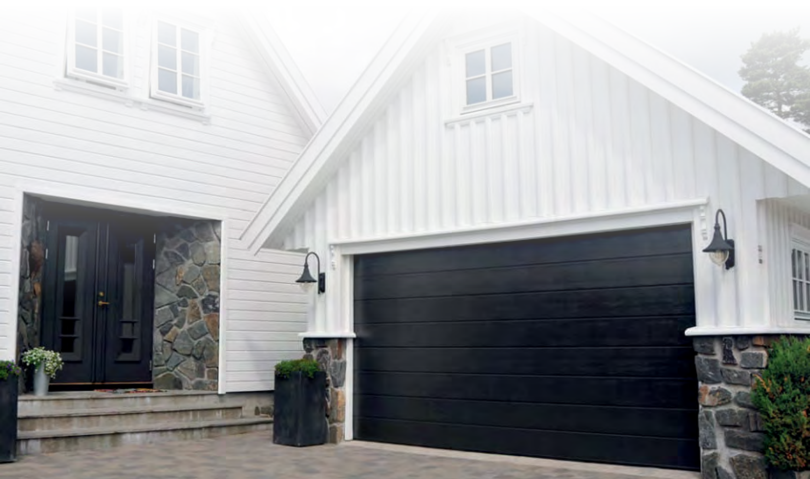
Midt-rib stålport med trestruktur malt i lik farge som inngangspartiet
